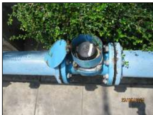
รูปที่ 1-4 ระบบท่อรับน้ำประปาจาก กปน.ด้านหน้าโครงการ
