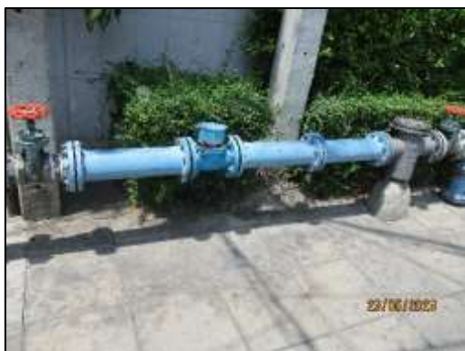
รูปที่ 1-4 ระบบท่อรับน้ำประปาจาก กปน.ด้านหน้าโครงการ
